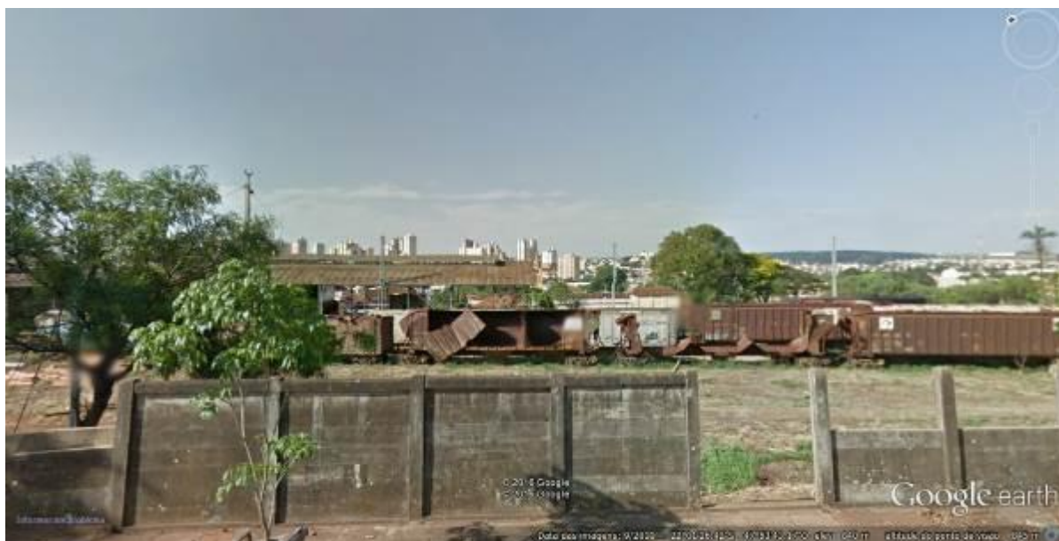
Figura 5: Equipamentos ferroviários abandonados da antiga Estação Ferroviária
